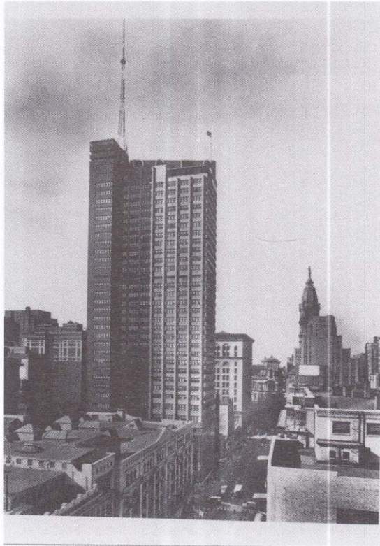
٣٣. فيلاديلفيا، مبنى جمعية صندوق توفير بنسلفانيا ، جورج هاو وويليام ليسكاز ، ١٩٢٢ .
