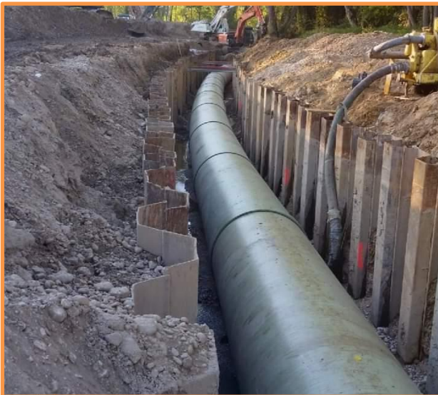
وصلة المواسير الفبيرجلاس (GRP) باستخدام الجببوت الزهر
