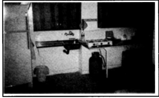
مطبخ معدّل: ارتفاع المغسلة وطاولة العمل ملائم لاستعمال الكرسي المتحرك وادخاله تحتها. (المساعدات الشعبية النروجية - لبنان).
