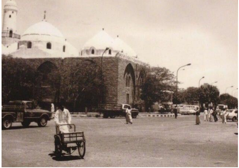
صورة قديمة لمسجد الغمامة
